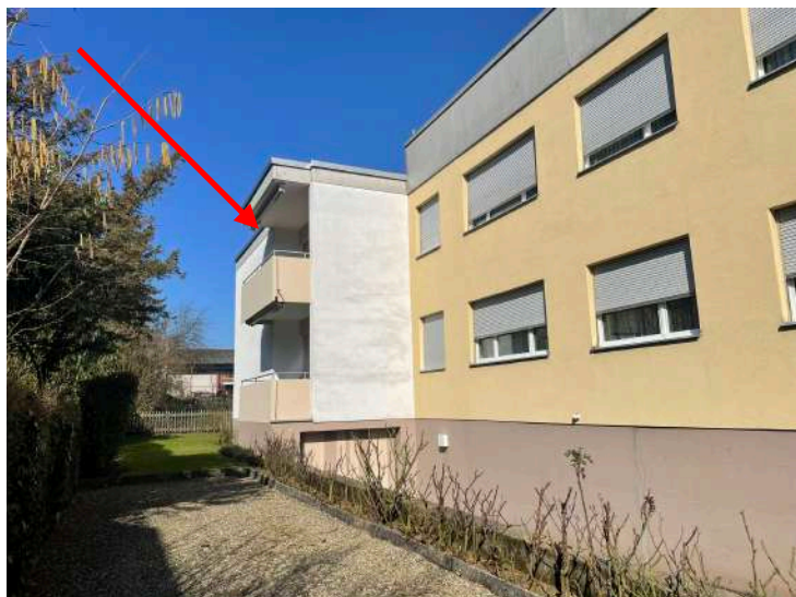
Ansicht West, Fassadenrückseite
