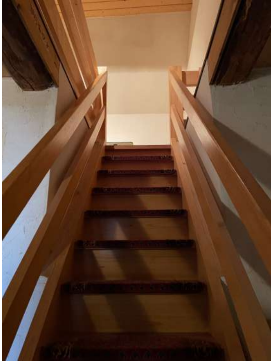
Treppe ins DG
