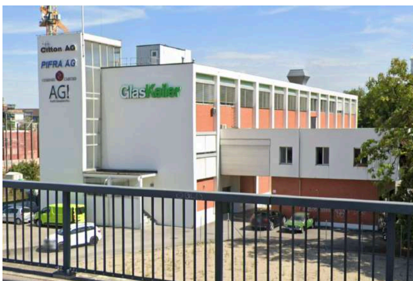
Ansicht NordWest mit Annex-Gebäude
