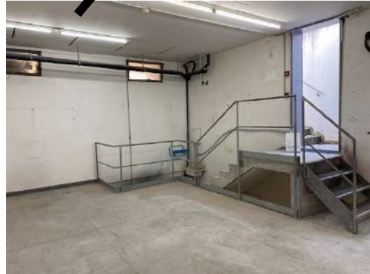
EG mit Zugang interne Treppe
